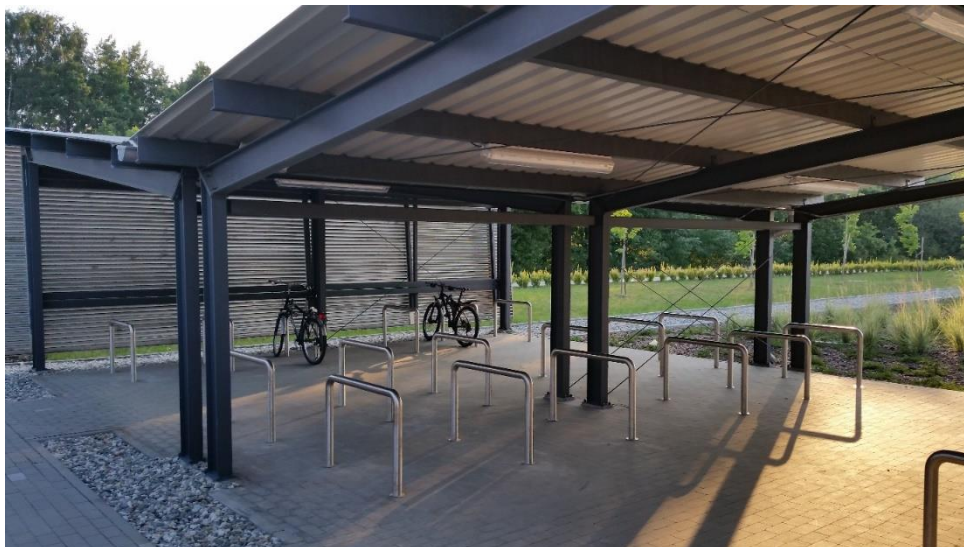
Fot. 2.2 Przykład stojaków rowerowych typu odwrócone ucho na parkingu Bike and Ride w Tychach Źródło: materiały własne
