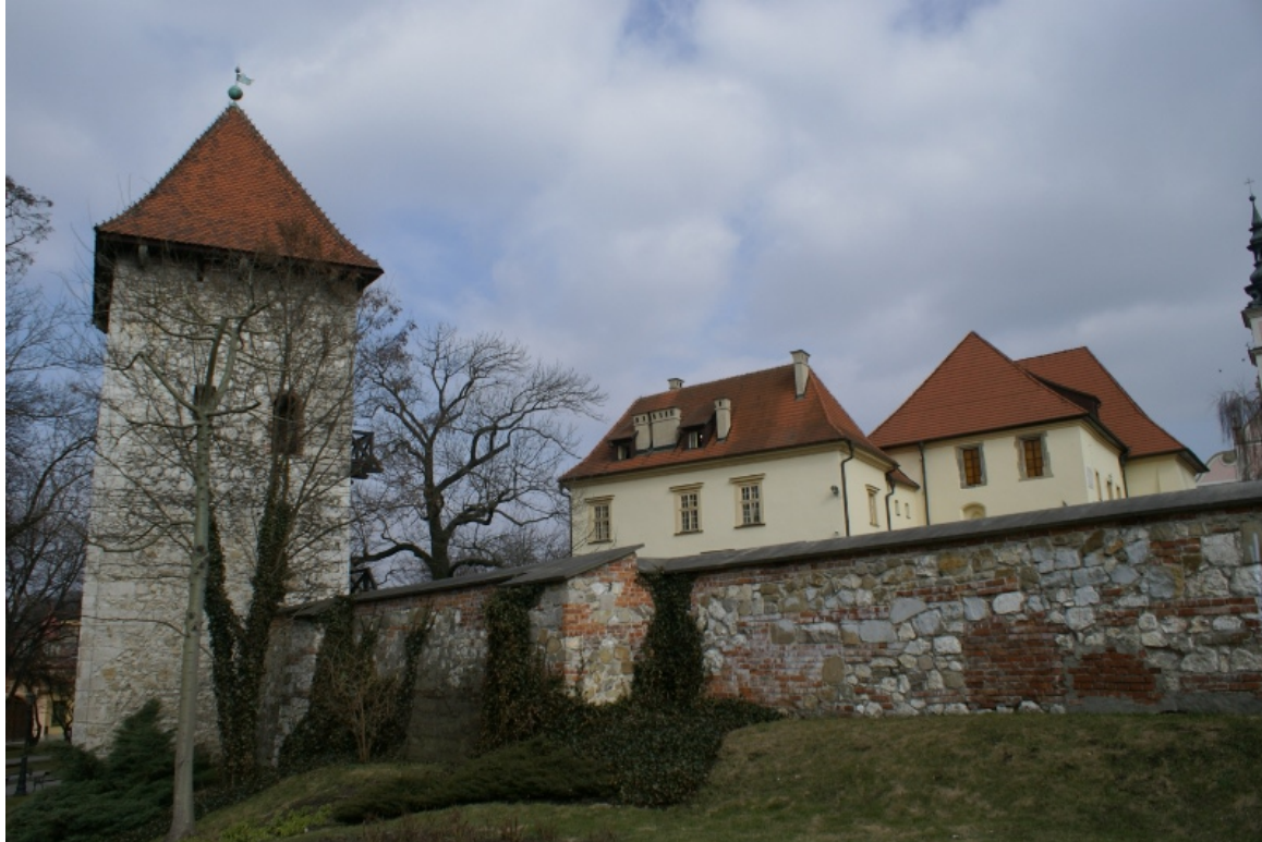
2) Muzeum Żup Krakowskich Wieliczka, na sfinansowanie remontu elewacji muru wschodniego w kompleksie Zamku Żupnego w Wieliczce; kwota 55 000 zł
